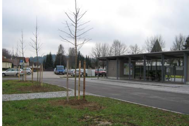
Neu gestaltetes Bahnhofsgelände
