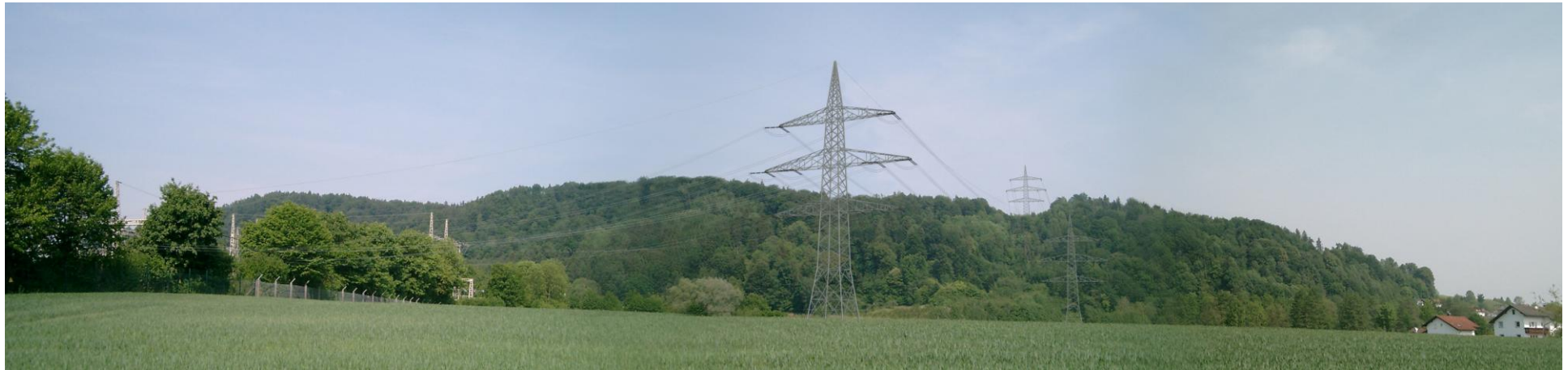
Abbildung 5: Ausgangssituation mit der bestehenden 220-kV-Freileitung
