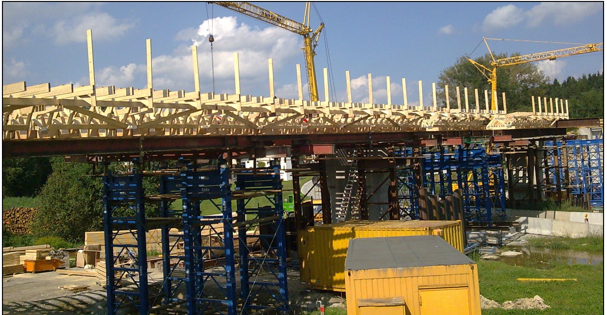
Bild 13 Traggerüst
