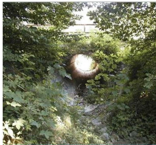
Abb. 2: Wellstahldurchlass am Schatzlöder Graben (Quelle: StBA Passau)
