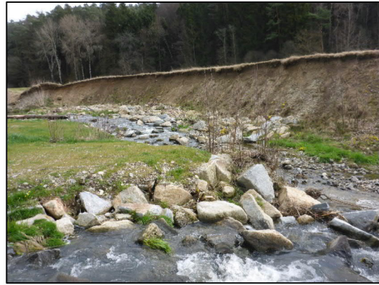
Abb. 8: Erosionsufer am Tanner Bach südl. der Ortschaft Gasteig, Blick nach Nordosten gegen die Fließrichtung
