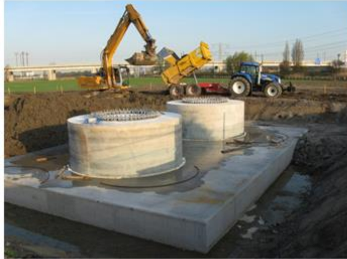
Abbildung 10: Vollwandmast mit zwei Türmen
