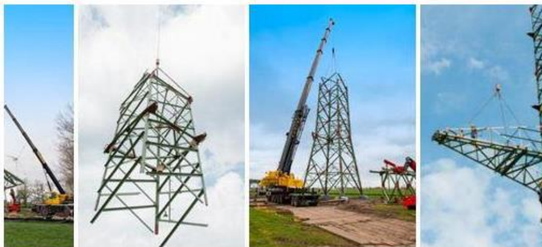
Abbildung 61: Mastmontage mittels Mobilkran
