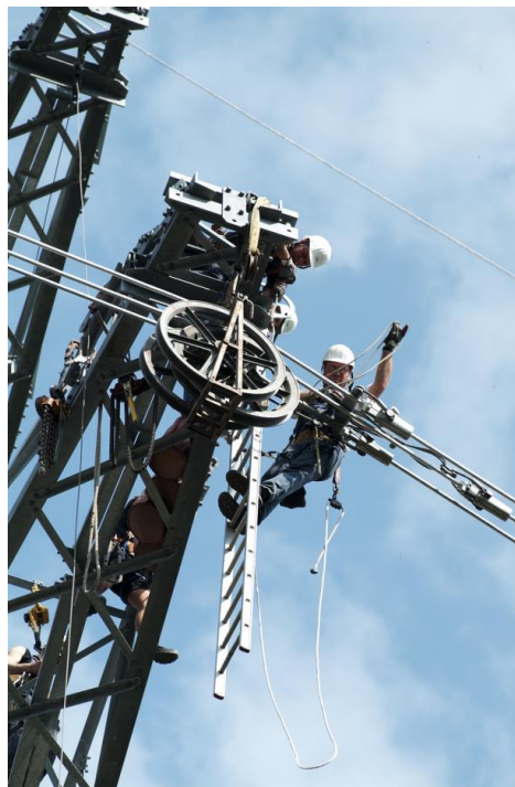
Abbildung 62: Leiterseile liegen während des Seilzugs in den Laufrollen
