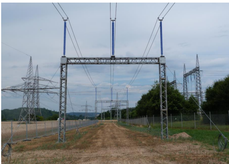
Abbildung 39: Freileitungsprovisorium für ein System mit Abankering
