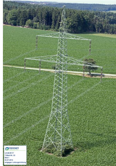
Abbildung 9: 380-kV-Mast Nr. 23 der 380-kV-Ltg. Isar – Pleinting (B117)
