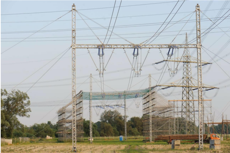
Abbildung 63: Freileitungsprovisorium
