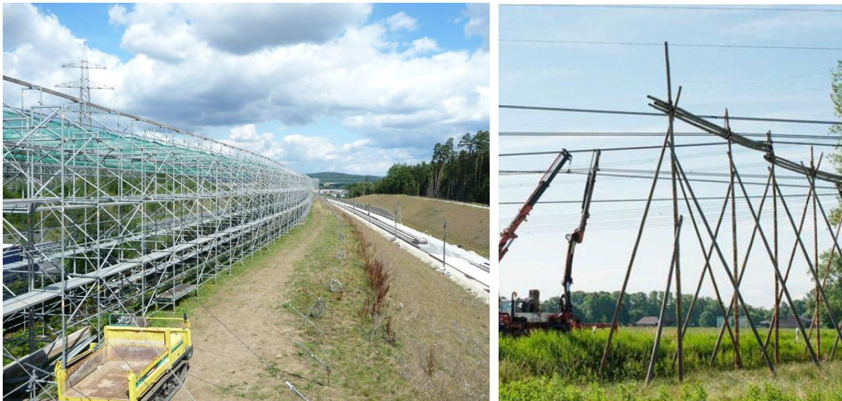
Abbildung 64: Schutzgerüste aus Metall und Holz
