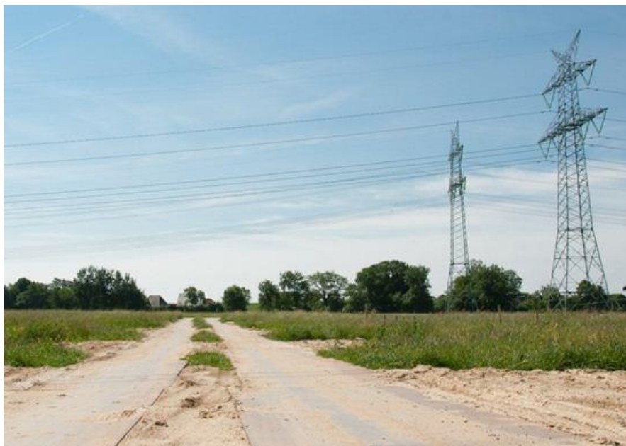
Abbildung 59: Beispiel für eine temporäre Mastzufahrt
