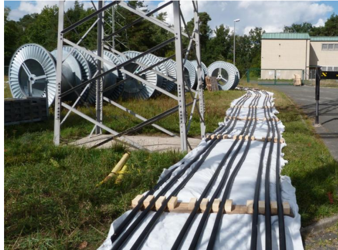
Abbildung 40: Baueinsatzkabel
