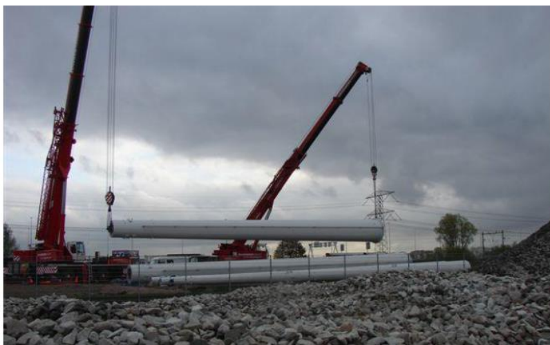
Abbildung 11: Aufstellen von Vollwandmasten mit Kränen
