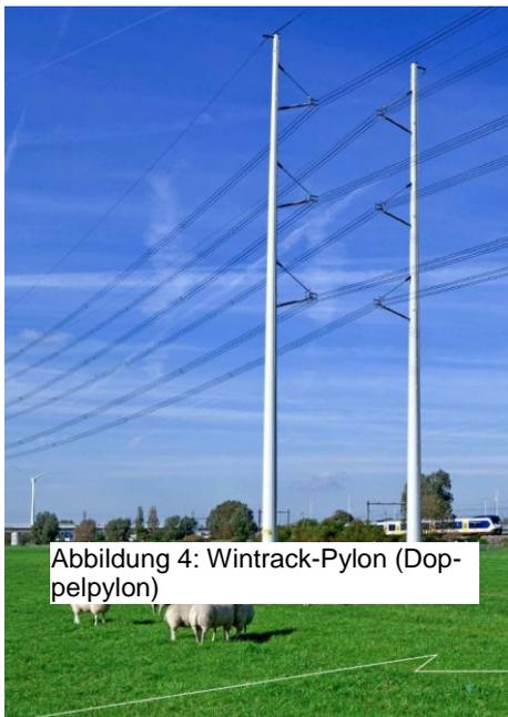
Abbildung 4: Wintrack-Pylon (Doppelpylon)
