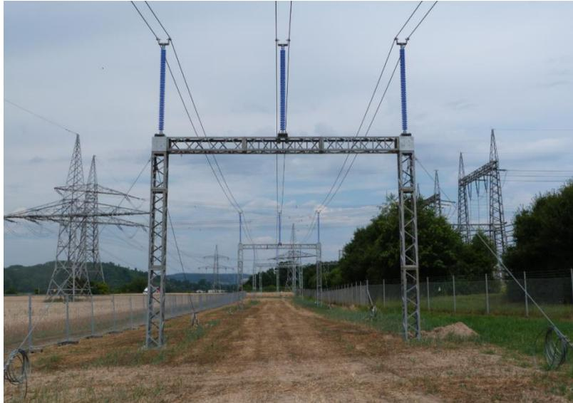
Abbildung 17: Freileitungsprovisorium für ein System mit Abankerung
