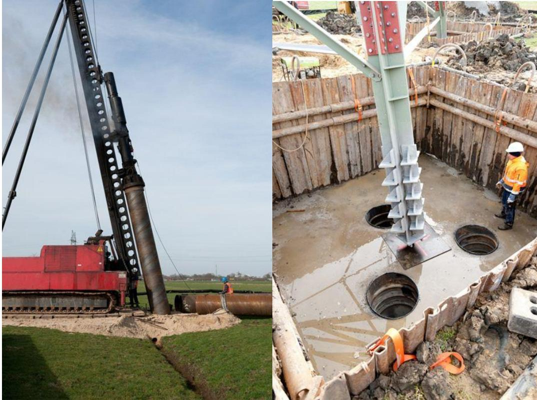
Abbildung 24: Beispiele für Fundamentarbeiten (Rampfpfahlfundament)
