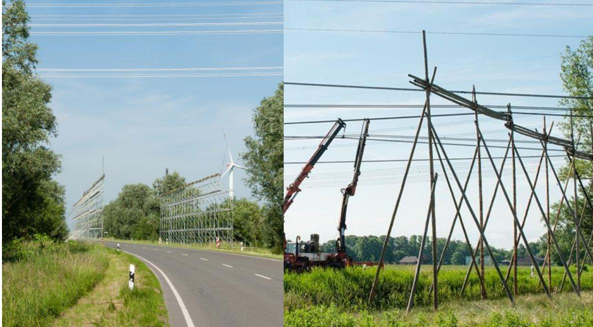
Abbildung 26: Schutzgerüst aus Stahlrohr oder Holz
