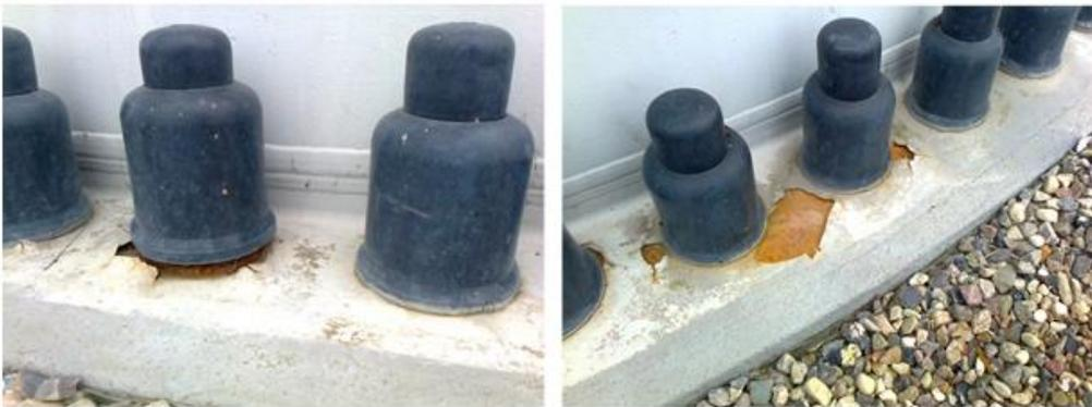
Abbildung 10: Korrosionsprobleme im Flanschbereich bei Vollwandmasten
