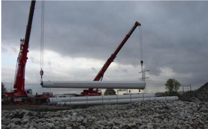
Abbildung 9: Aufstellen von Vollwandmasten mit Kränen
