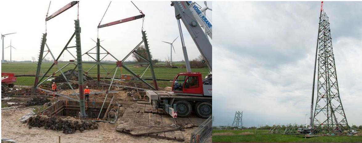
Abbildung 25: Beispiel für Maststockung und -montage
