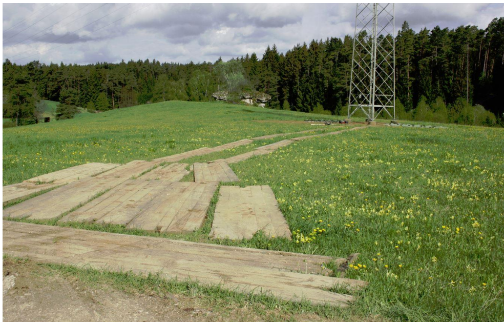
Abbildung 15: Bsp. Zuwegung über Holzplatten
