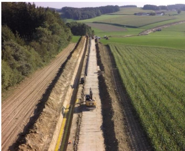
Abbildung 9: Bsp. Kabelverlegung mit offener Bauweise
