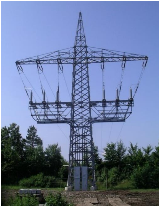
Abbildung 8: Bsp. Kabelübergangsmast
