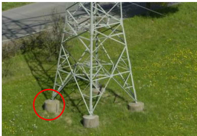
Abbildung 6: Bsp. sichtbare Betonfundamentköpfe
