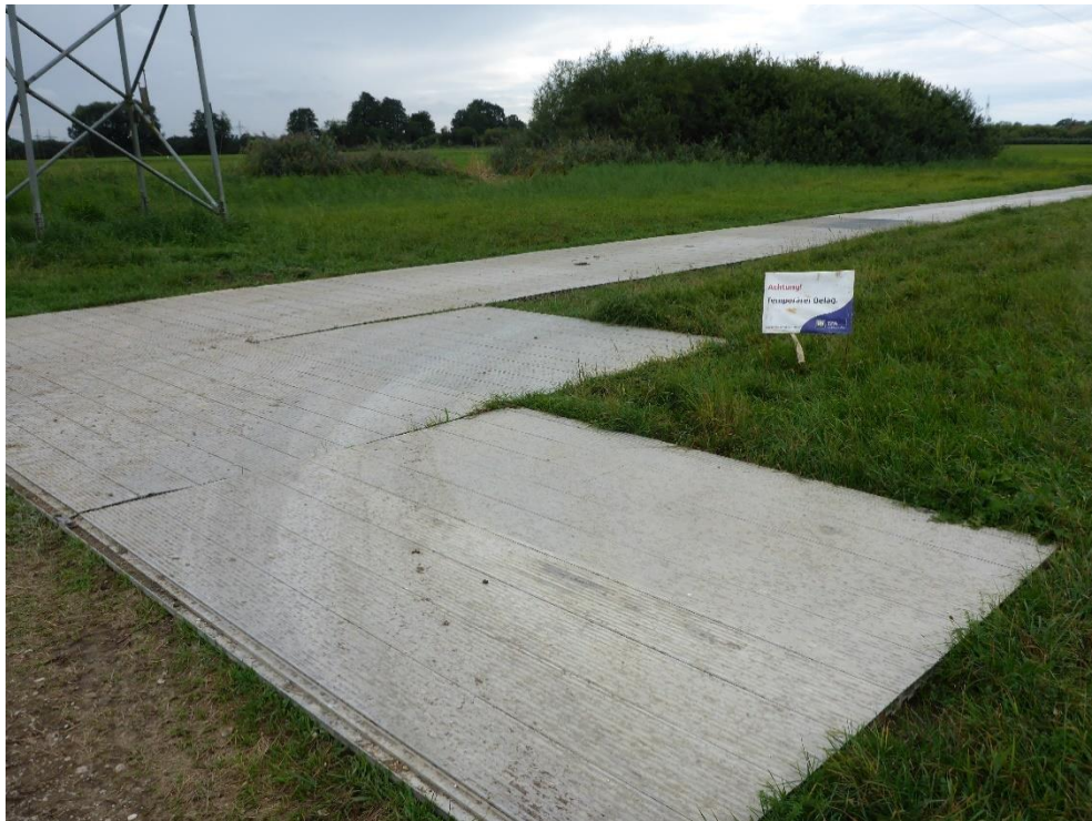
Abbildung 14: Bsp. Zuwegung über Aluplatten
