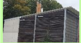
Nisthilfen für Gebäudebrüter an öffentlichem Gebäude (Foto Stadt Rottenburg)
